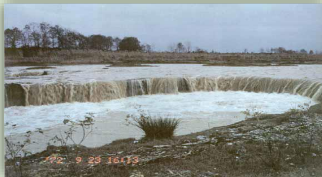
نمایی از گودال ناشی از برداشت شن و ماسه در رودخانه تالار
