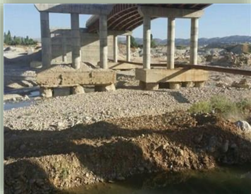
نمایی از گودال ناشی از برداشت شن و ماسه در رودخانه تالار
